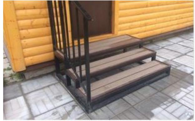
**Рис. 17б. Крыльцо, не включаемое в контур здания**
