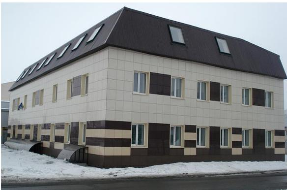
**Рис. 18а. Крыша, не включаемая в контур здания**
