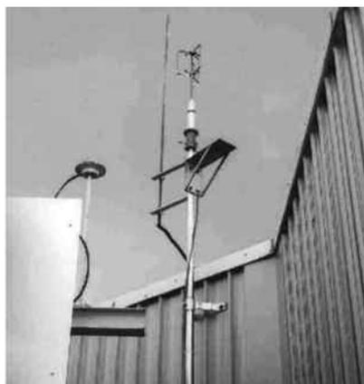
Рис. 8. Установка одной из антенн GPS и анемометра на крыше отеля Плаза.
