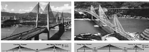
Рис. 10 Общий вид мостов (вверху) и схемы установки GPS приемников (внизу).
