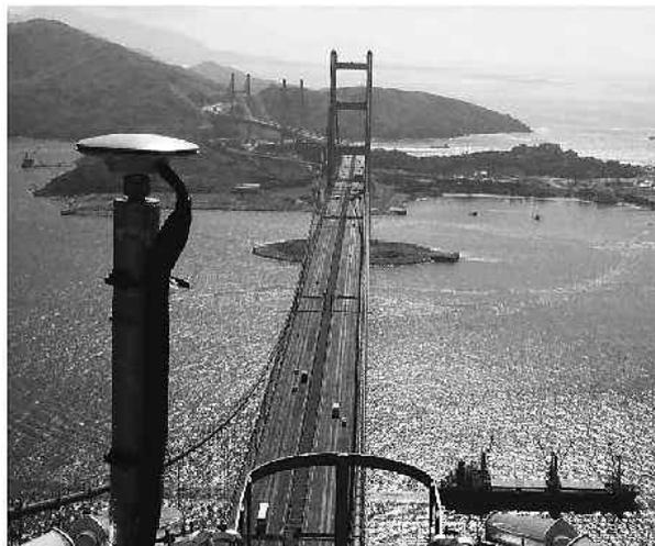
Рис. 11 Установка GPS антенны на опоре вантового моста.
