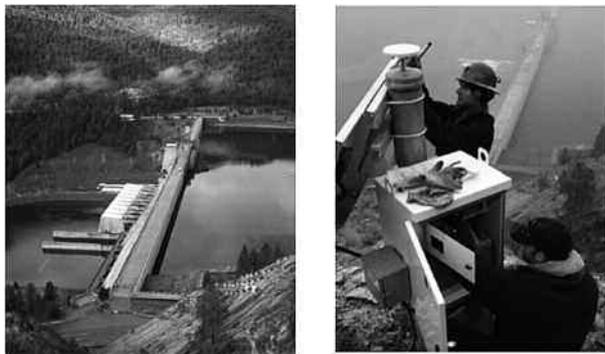
Рис.5 Плотина Либби и установка GPS станции на скальных породах склона водохранилища.
